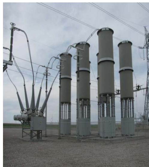
Рис. 1 Сухой шунтирующий реактор на 345 кВ, 20 МВА, 60 Гц, 3 фазы
