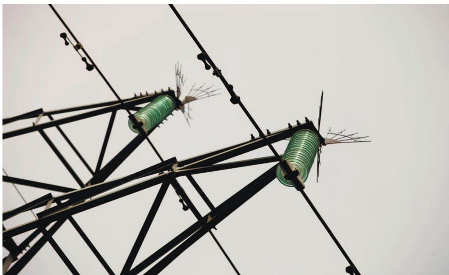
Рис. 1. Антиприсадочное ПЗУ ЗП-АП2-2
