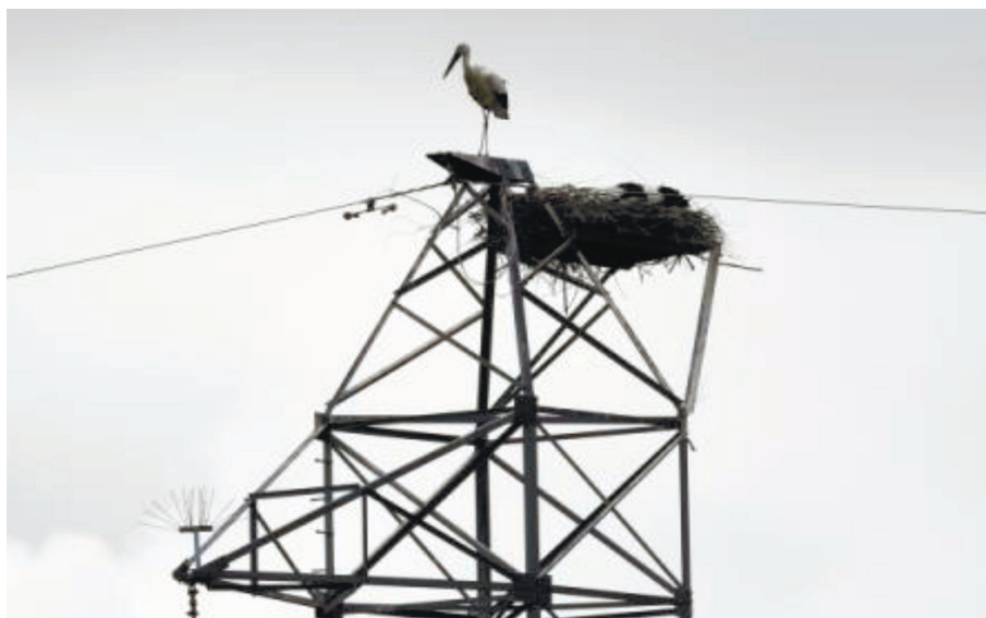
Рис. 3. Устройство, препятствующее гнездованию птиц
