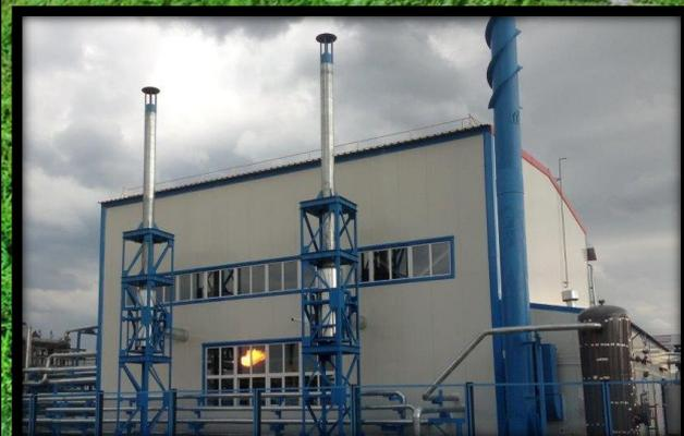
Утилизация попутного нефтяного газа с целью выработки тепловой и/или электрической энергии
