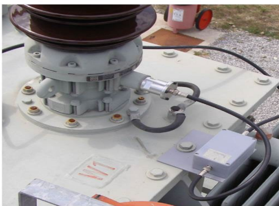
рис. 8. (а) Подключение к измерительному выводу; (б) Система контроля переходного перенапряжения, установленная на шунтирующем реакторе мощностью 100 МВА
