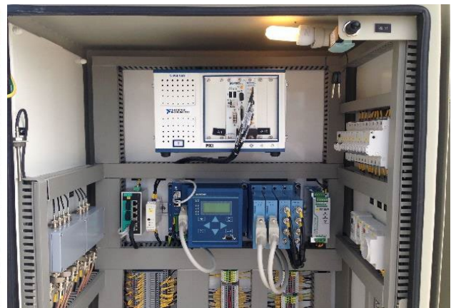
рис. 8. (а) Подключение к измерительному выводу; (б) Система контроля переходного перенапряжения, установленная на шунтирующем реакторе мощностью 100 МВА
