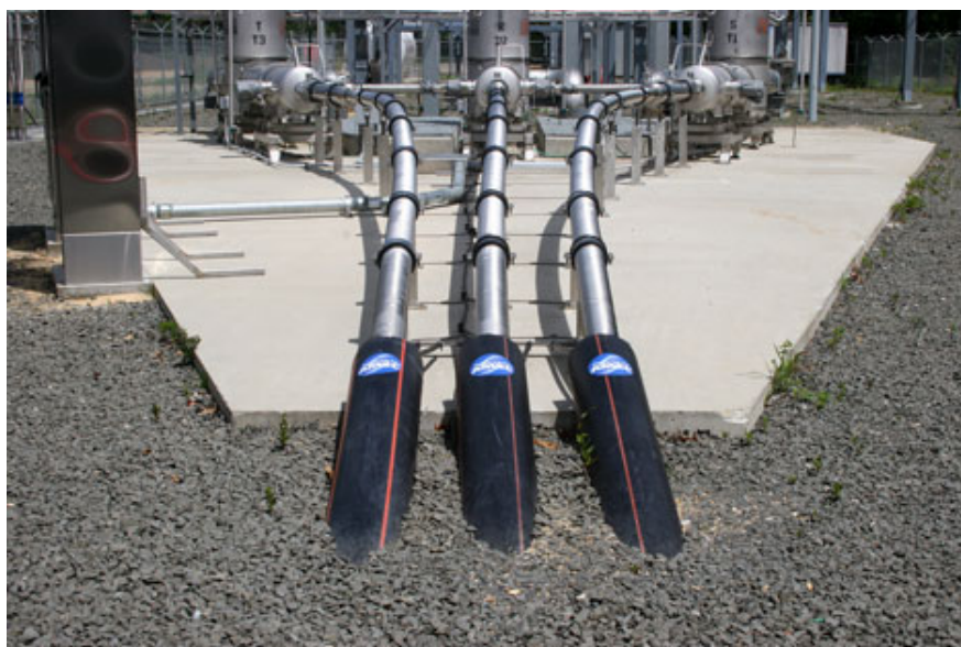
Рисунок 8 - Первая сверхпроводниковая кабельная линия. Лонг Айленд, США
